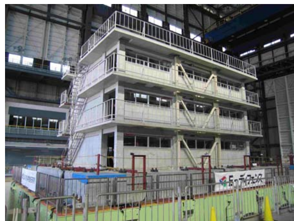
【耐震補強した学校校舎】
